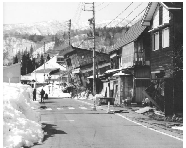
(多数の家屋が損壊した横倉地区)
